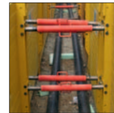
Fernwärme-Rohrverlegung im Verbau - Unterföhring
