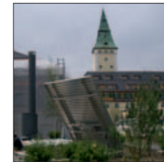
Offener Bunkerdeckel Biomasseheizwerk - Schloss Elmau
