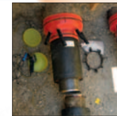
Pressung DN 600 unter S-Bahnstrecke in Feldkirchen
