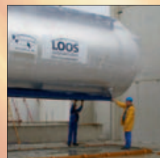
Einbringen Spitzenlastkessel - AFK Geothermie
