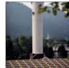
Montage Kaminanlage - Heizwerk Ruhpolding
