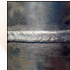
Schweißnaht am Fernwärmerohr Oberhaching
