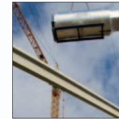
Krantransport - Spitzenlastkessel Geovol Unterföhring
