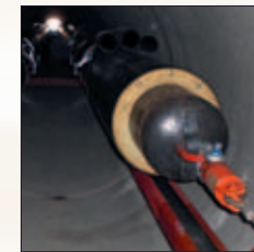
Einziehung FW-Rohr in Schutzrohr unter A8
