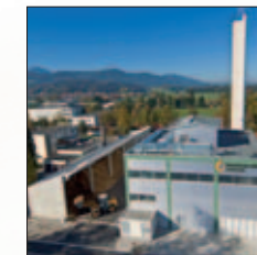
Biostrom und -wärme - Heizwerk Ainring
