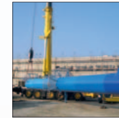
Anlieferung Kaminanlage - AFK-Geothermie
