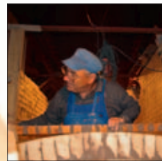
Ausmauerung 20 t Schamott Biomasse-Heizwerk Ainring
